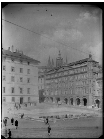
4. Water Reservoir on Lesser Town Square Address: Malostranské náměstí, Praha 1 GPS: 50.088282N, 14.404237E
