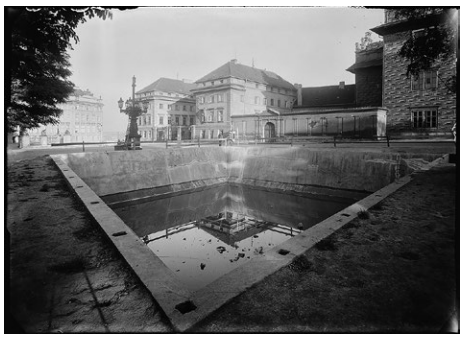
3. Water Reservoir on Hradčanské Square Address: Hradčanské náměstí, Praha 1 GPS: 50.0896075N, 14.3968883E
